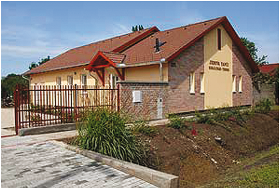
A szentesi Királyság-terem építése és elkészült állapota
